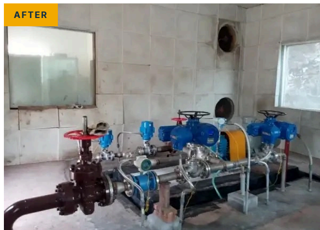
EHK pitot tube pump · 45 kW (60 hp) motor
